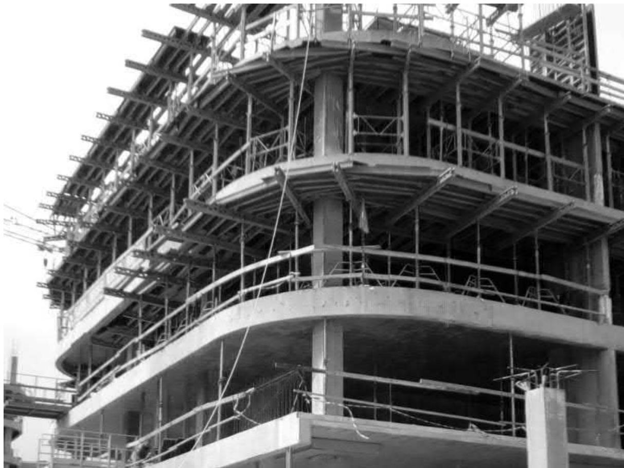
Рисунок 2 – Процесс строительства межэтажных перекрытий монолитного дома
