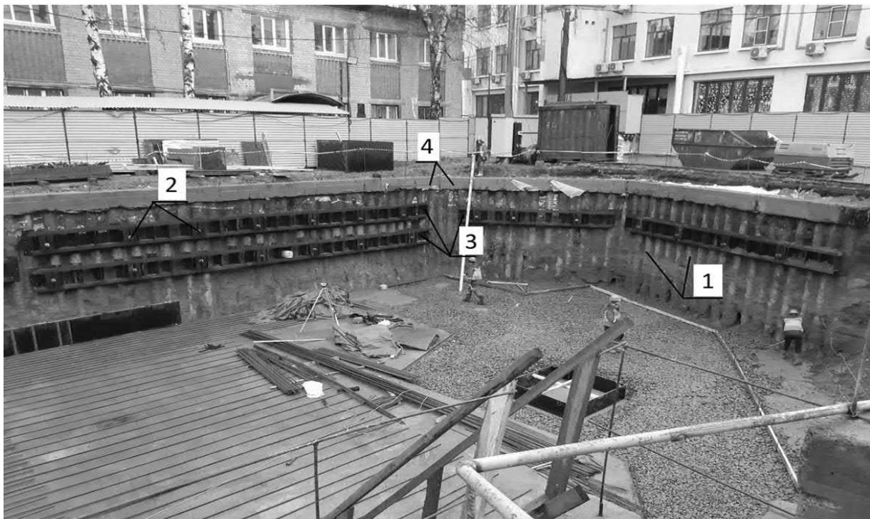
Рисунок 6, б – Фрагмент плана ограждения котлована: 1 - буроинъекционные сваи ЭРТ; 2 - грунтовые анкера ЭРТ; 3 - анкерный обвязочный пояс; 4 - монолитный железобетонный обвязочный пояс
