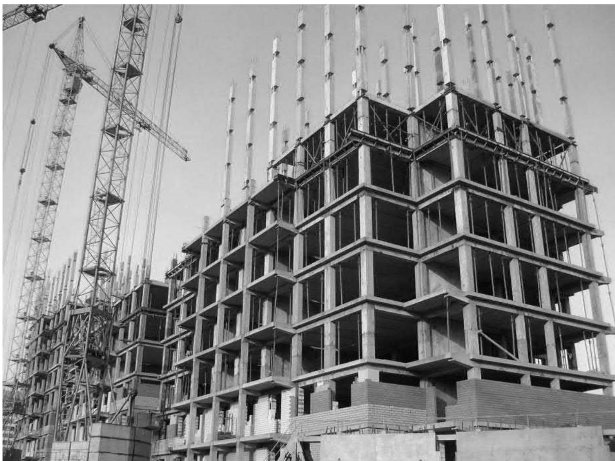
Рисунок 1 – Строительство сборно-монолитного каркаса жилого здания
