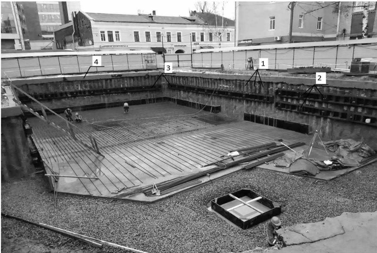
Рисунок 6, а – Фрагмент плана ограждения котлована: 1 - буроинъекционные сваи ЭРТ; 2 - грунтовые анкера ЭРТ; 3 - анкерный обвязочный пояс; 4 - монолитный железобетонный обвязочный пояс
