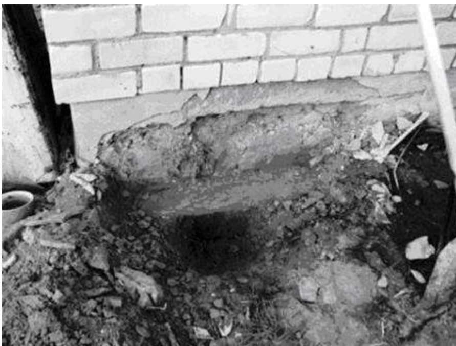
Рисунок 1 - Вскрытие фундаментов
