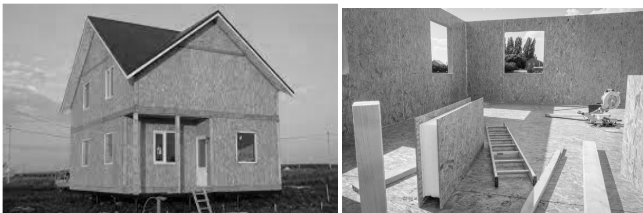
Рисунок 1 - Технология строительство дом из Sip панелей
