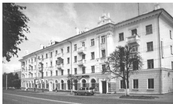
Рисунок 4 - Общий вид жилого дома электроаппаратного завода. 1950-е гг. Фото 2011 г.
