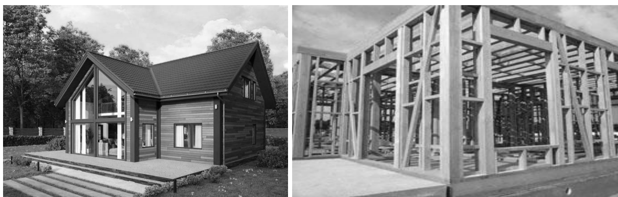
Рисунок 2 - Технология строительства финского деревянного каркасного дома
