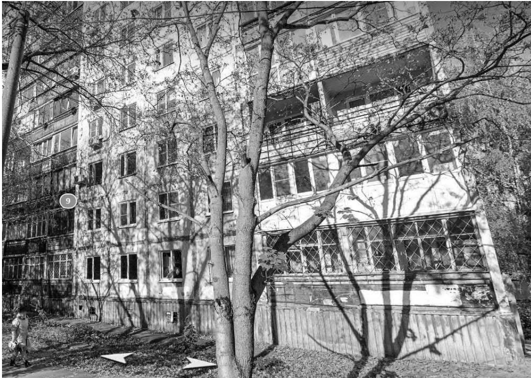
Рисунок 1 – Фотография 9-этажного крупнопанельного жилого дома, г. Нижний Новгород, ул. Володарского, 9
