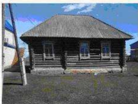
Старое здание почтового отделения.
