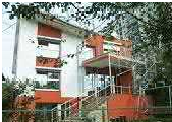
Рисунок 4 - Пример почти полного остекления с южной стороны (пассивный дом в Киеве, арх. Т.Эрнст)
