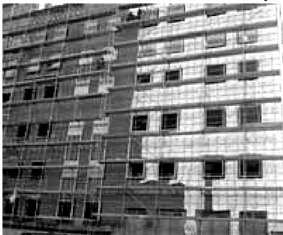
Рис. 2. Реконструируемое здание в Чебоксарах с монтируемым фасадом с алюминиевой подконструкцией
