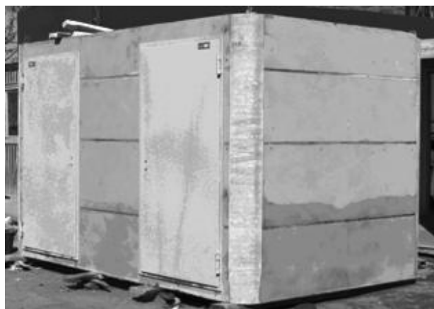
Рисунок 3 - Замкнутая сталефибробетонная кабина, выполненная методом сухого торкретирования
