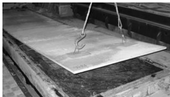
Рисунок 4 - Распалубка сталефибробетонного листа толщиной 30 мм
