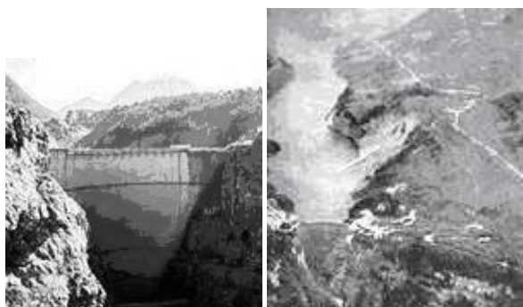
а б Рисунок 5 - Авария на плотине Вайонт в Италии; а – плотина, б – водоем и оползень; погибло 2000-3000 человек.
