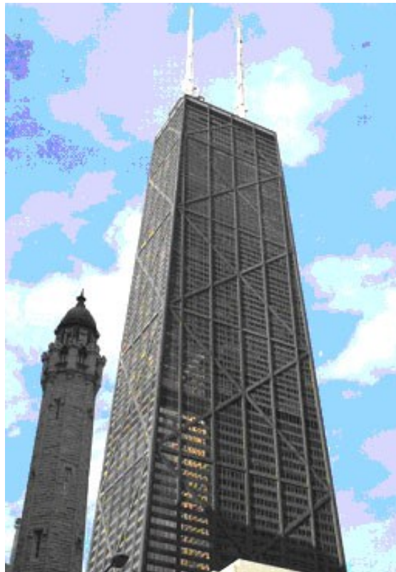
100-этажное здание Хинкок-билдинг в Чикаго. США. Брюс Грэм. 1969г, 344м
