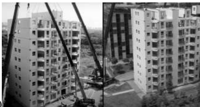
Рисунок 5 – Модульное здание: а) монтируемый модуль; б) возведенное здание
