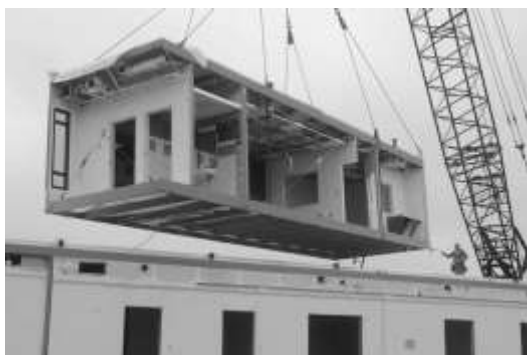
Рисунок 5 – Модульное здание: а) монтируемый модуль; б) возведенное здание
